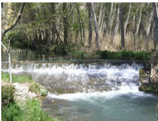
Foto 8: Azud "Presa Molino de Landete", donde se propone la instalación de un dispositivo de paso de peces
